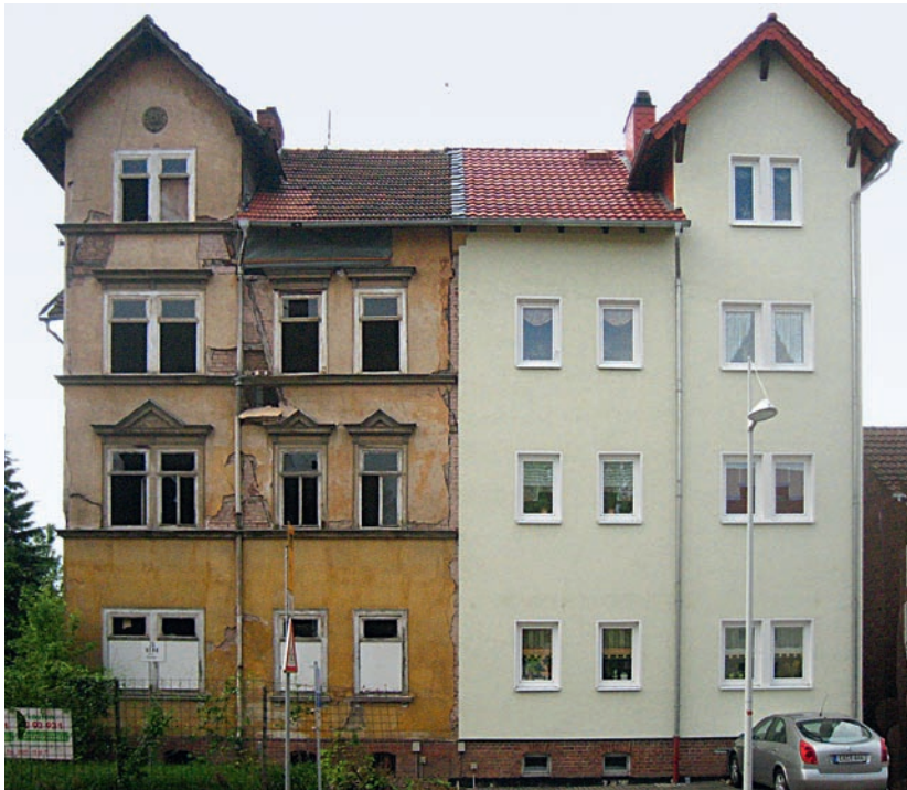
Abb. 10: Haus nach/vor einer energetischen Sanierung in Eisenach, Foto: Max von Trott
