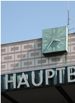
Braunschweig, Hauptbahnhof Detail Foto: Ulrich Knufinke, 2012
