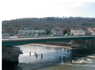
Die Baustelle der neuen Münsterbrücke im April 2013 Foto: NLSTBV
