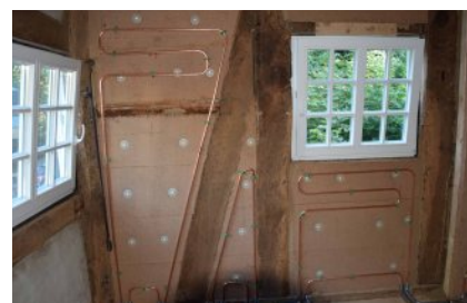
oben: Die Wassermühle nach der Sanierung unten: Wandheizung auf Holzfaserdämmung Fotos: Ralf Jenßen
