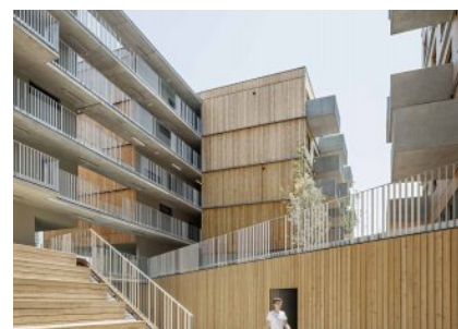
Holzwohnbau Seestadt Aspern, Wien Foto: Herta Humaus
