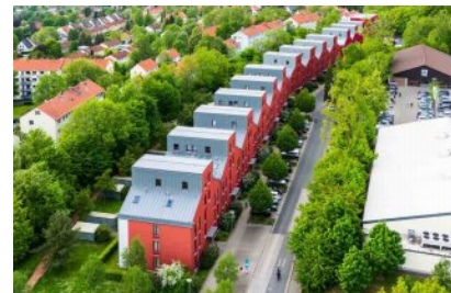
Die „Rote Reihe“ in Göttingen. Bauherrin: Städtische Wohnungsbau Göttingen, Architekt Sergio Pascolo, Venedig. Freiraumplanung SPALINK-SIEVERS Landschaftsarchitekten. Foto: Mehle
