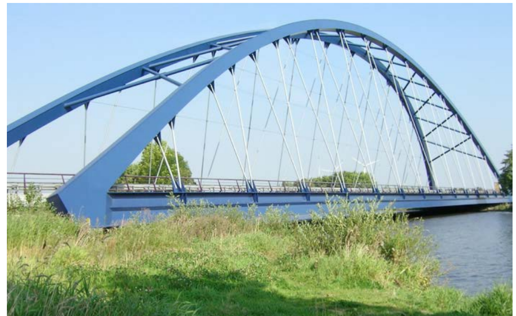
Bundesstraße 473, Brücke über die Lune
