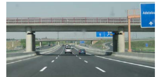
A7 bei Göttingen, technische Planung und Gestaltung NLSStBV
