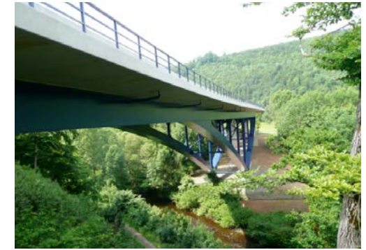
Bundesstraße 243, Bad Lauterberg, Brücke Lau1
