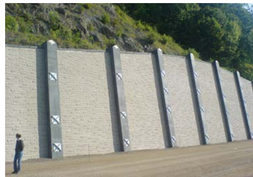
Bundesstraße 27, Stützwand Bad Lauterberg, technische und gestalterische Planung: NLSStBV
