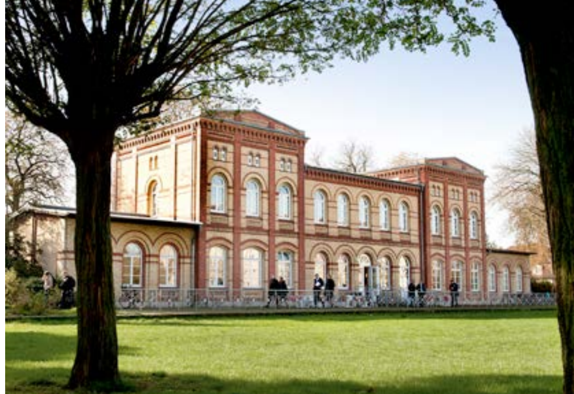
Veranstaltungsort: Haus der Kulturen, Am Nordbahnhof 1A, 38106 Braunschweig
