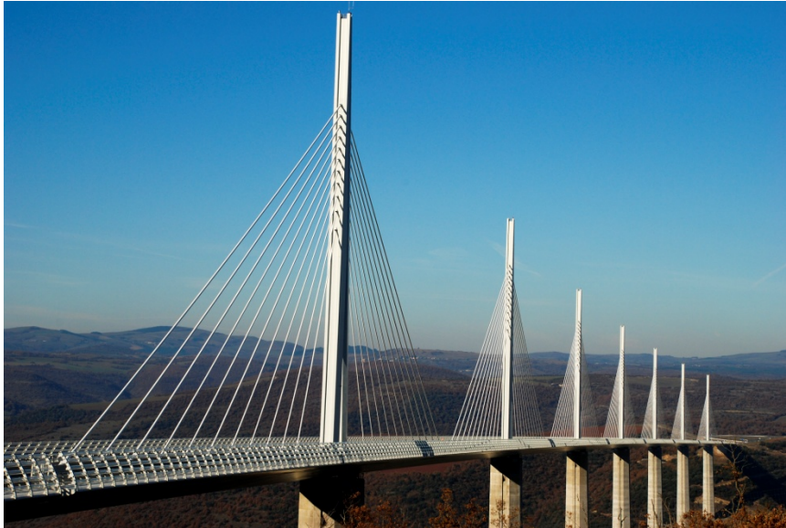
34.1 // Bild: Viadukt von Millau . Frankreich. Derzeit die höchste Brücke der Welt und Zeichen von Ingenieursbaukunst. Quelle: Anke van de Wiel
