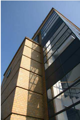
Detail Faguswerk in Alfeld
