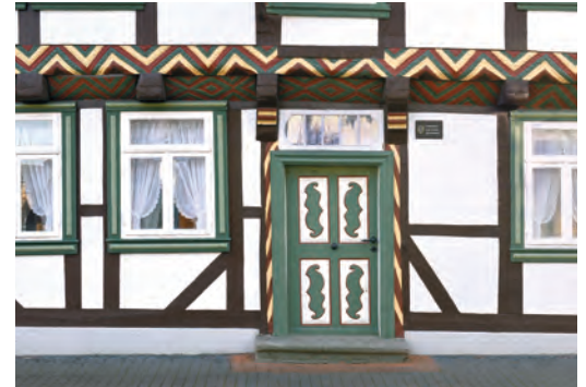
Die Alte Schmiede in Fallersleben, Foto: Lars Landmann
