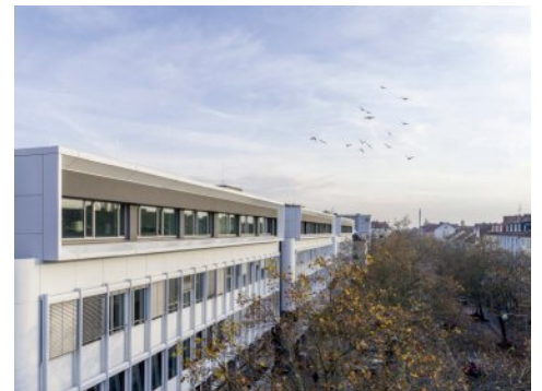
Modernes Wohnen in der Nähe von Hannovers Maschsee. Foto: BBU.ONSITE
